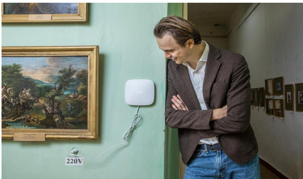
Рис. 3.1. Встановлення охоронної системи AJAX – для забезпечення безпеки експонатів перед початком масштабної кампанії
